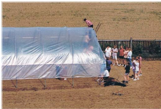
Errichtung des Folientunnels
